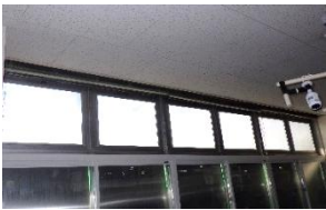
上部排煙窓ペアガラス化
